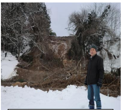
土砂で散乱する崩落現場
