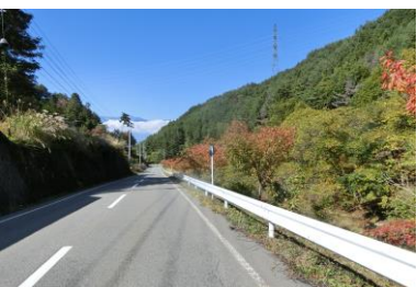
水圧管理設? 県道駒ヶ根長谷線
